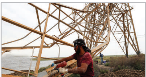
عملیات بازسازی خطوط انتقال برق
